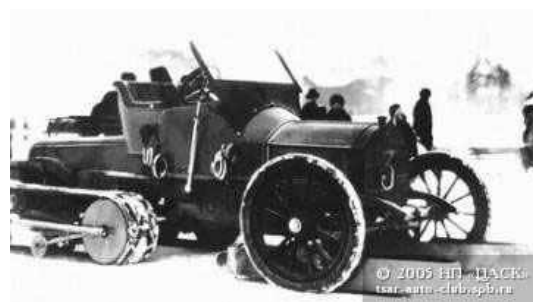
Рис. 51. Адольф Кегресс в Царскосельском императорском гараже на автомобиле Мерседес14-30 с гусеничным двигателем собственной конструкции. 1912 г.
