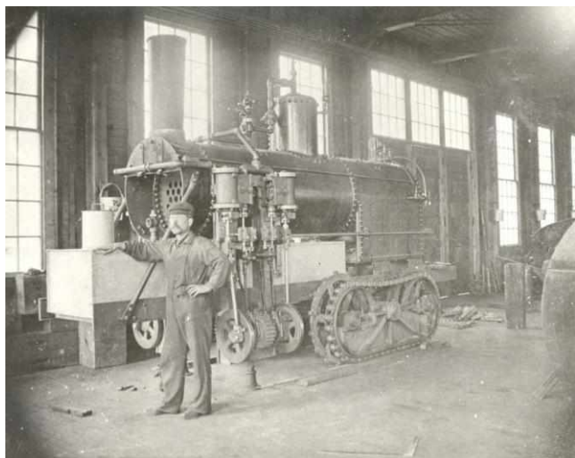
Рис. 24. Сборка полугусеничного трактора Элвина О. Ломбарда (1901 г.)
