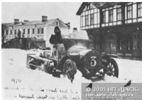
Рис. 51. Адольф Кегресс в Царскосельском императорском гараже на автомобиле Мерседес14-30 с гусеничным двигателем собственной конструкции. 1912 г.
